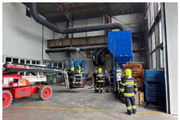
Brandmeldeanlage erkennt Brand 2025-07-23
